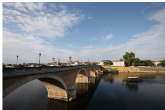
Korjaus ei käytössä
