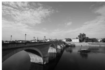
Korjaus ei käytössä
