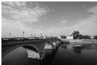
Korjaus ei käytössä
